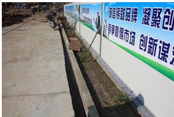
施工场地周边排水沟边沟(2015年12月)
