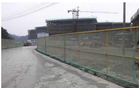
场内道路防尘网防护(2016年3月)
