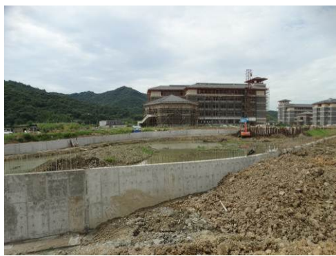
正在施工的人工湖(2017年6月)
