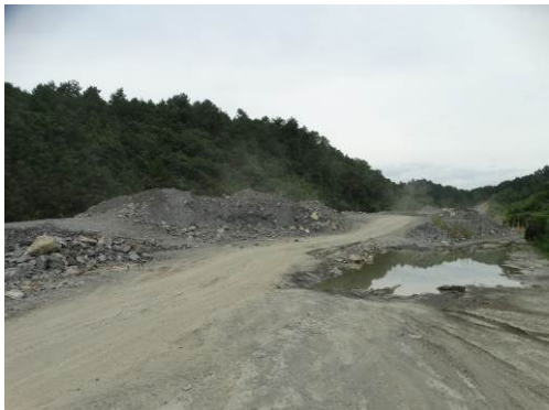
临时堆渣场(2017年6月)
