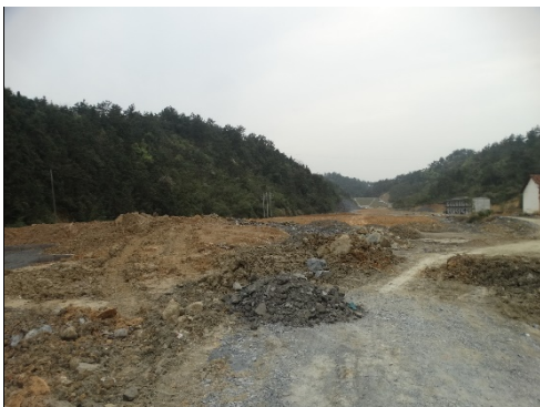
临时堆渣场场地清理(2018年3月)
