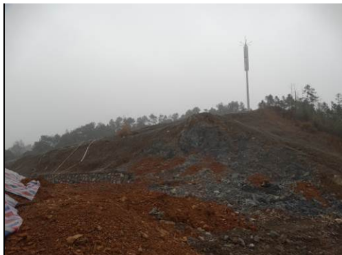
开挖边坡 TBS 施工 (2017年12月)
