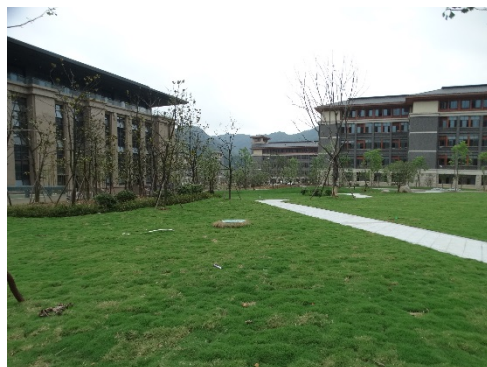
教学区已完成绿化的面貌(2018年6月)
