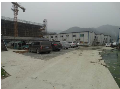
施工临时场地(2016年12月)
