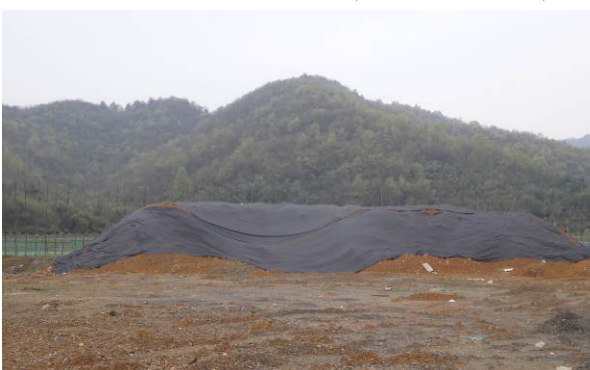
临时堆土土工布苫盖(2016年3月)
