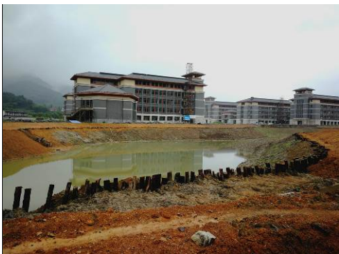
正在施工的人工湖(2017年9月)
