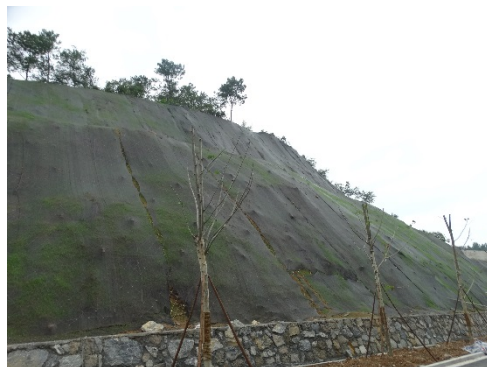
开挖边坡绿化面貌(2018年6月)
