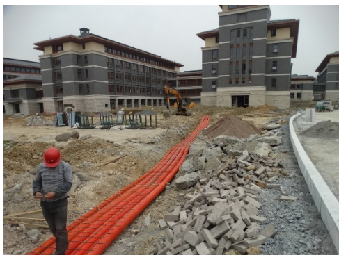
场地地埋管线施工(2018年3月)
