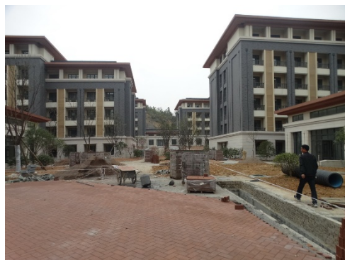
地砖铺设和植被栽植施工(2018年3月)
