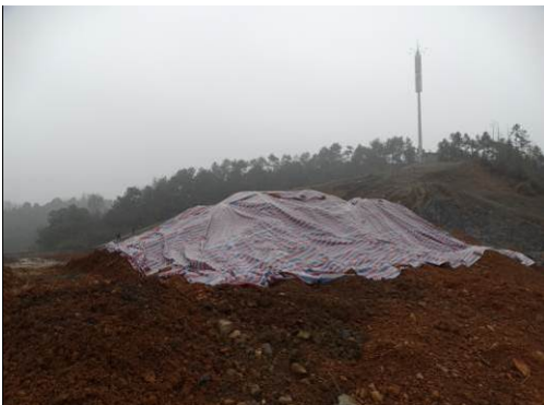
临时堆土覆盖(2017年12月)
