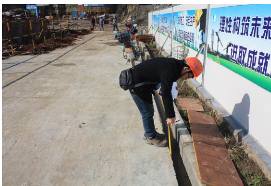
排水沟现场测量(一)
